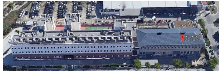
Centro Penitenciario Jerez de la Frontera.
